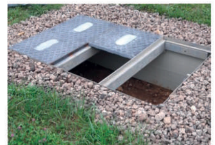
6. Die GFK-Abdeckungsplatten werden mit einem Deckelheber in den Rahmen eingesetzt.
