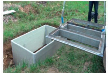
3. Den oberen Abschluss bildet der Kopfdistanzring mit vormontiertem Stahlrahmen. Diese müssen mit einem geeigneten Hebemittel auf den letzten Distanzring vollflächig aufgesetzt und verrastet werden.
