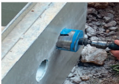
4. An entsprechenden Positionen die Anschlüsse für die Leerrohre mit einer Lochsäge in die Wand des Kabelverteilungskastens schneiden. Der Fuß- sowie der Kopfdistanzring dürfen hierbei nicht durchgebohrt werden.
