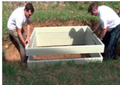
2. Den ersten vormontierten Distanzring als Fußdistanzring mit montiertem Boden positionieren und ausrichten. Jeden weiteren Distanzring aufsetzen und gleichmäßig mit dem jeweils unteren Distanzring verrasten.
