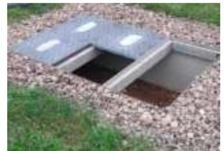
6. Les couvercles PRV sont déposés sur le cadre à l'aide de cannes de levage.
